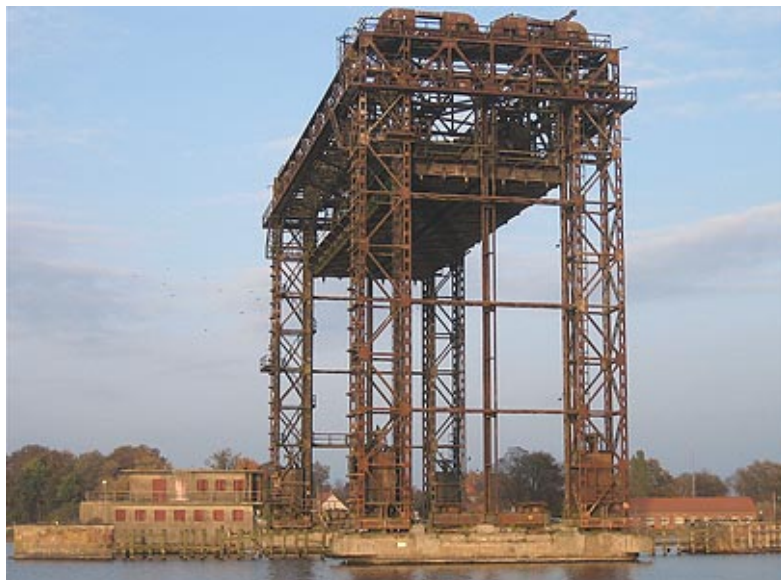
Baudenkmal Karniner Hubbrücke ohne Anschluß
