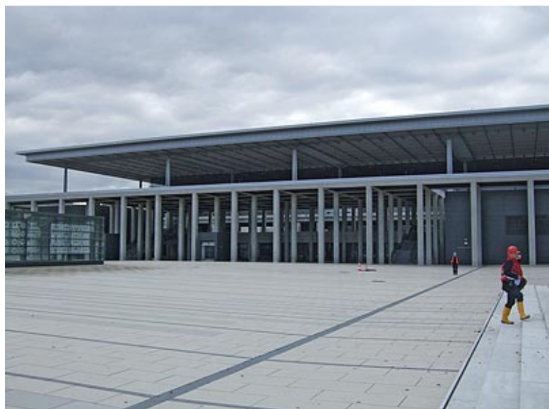
aufgeräumte Baustelle BER
