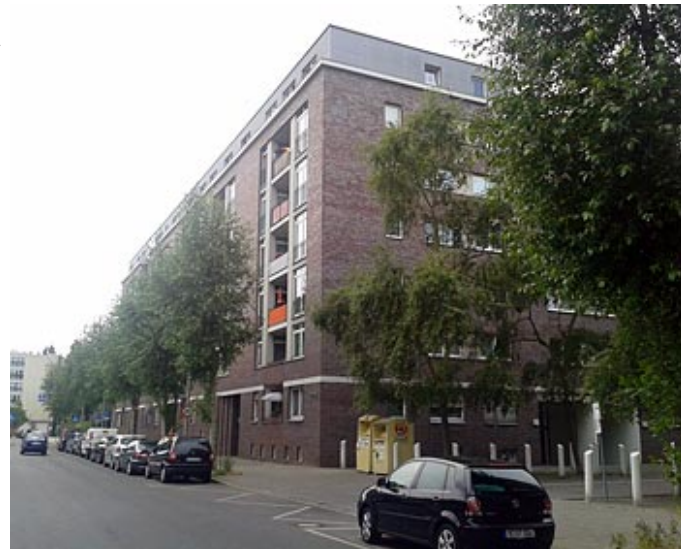
Mietwohnungen in der Wasserstadt
