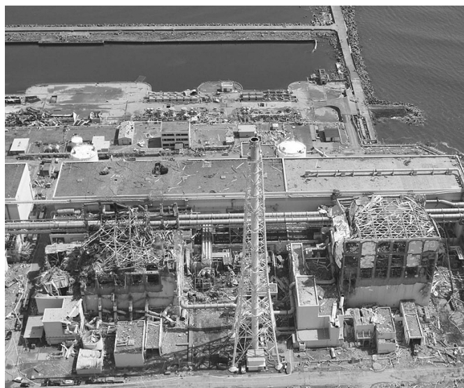
Block 3 und 4 im AKW Fukushima I Foto: Air Photo Service
