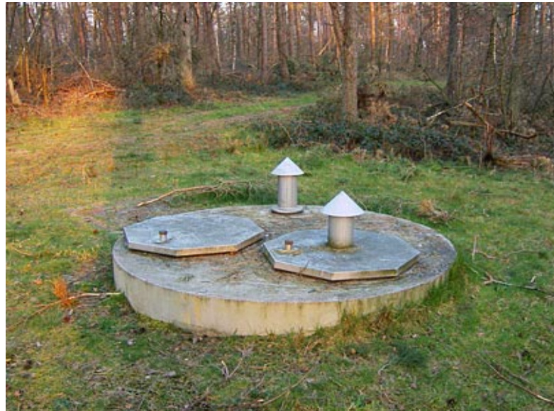
Tiefbrunnen zur Trinkwassergewinnung
