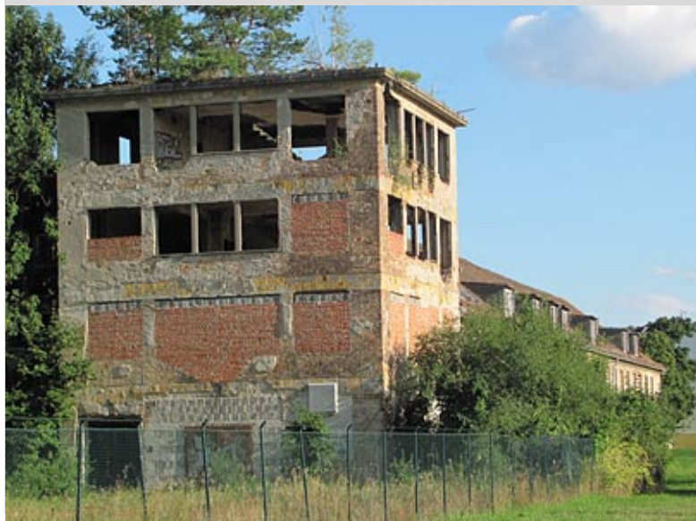
Verfallendes ehemaliges Krankenhaus in Staaken
