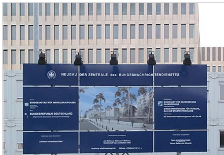
Großbaustelle BND in Berlin Mitte
