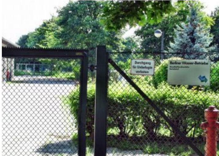
Eingang zum Betriebshof
