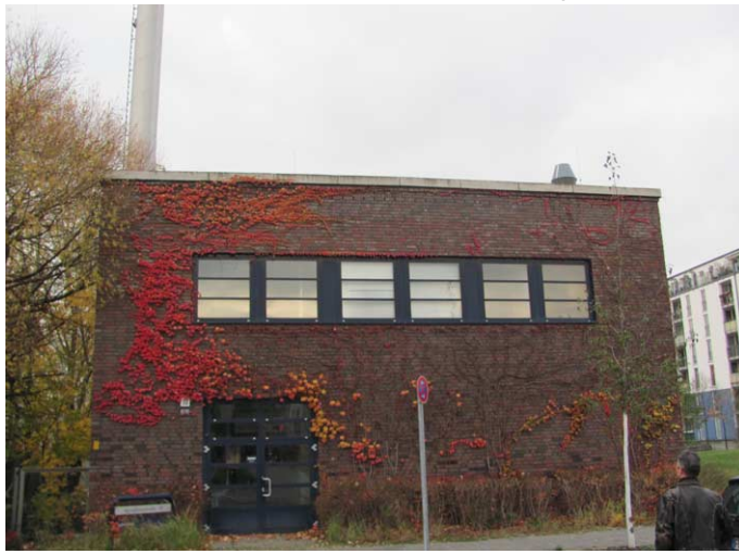
Blockheizkraftwerk in der Wasserstadt
